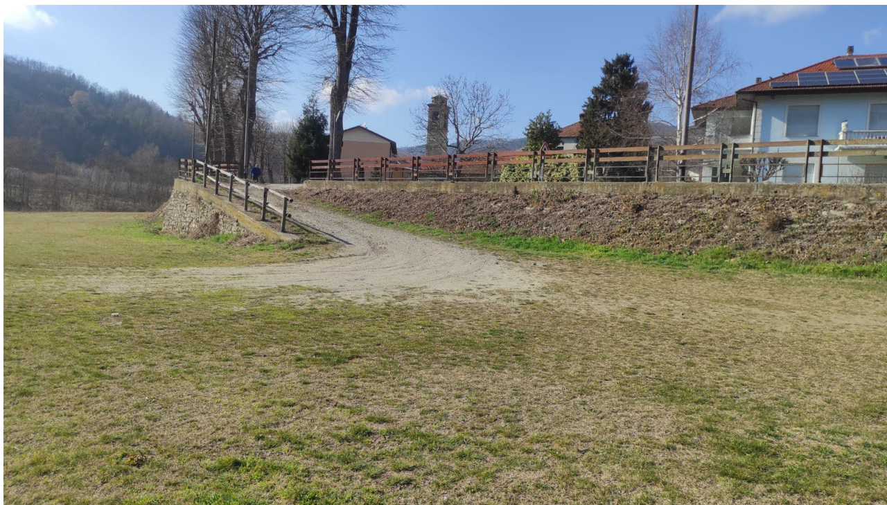
Figura 4: Sponda sinistra a monte ponte S. Rocco, Intervento 8, Demolizione e sostituzione parapetto metallico esistente per assenza di franco idrometrico
