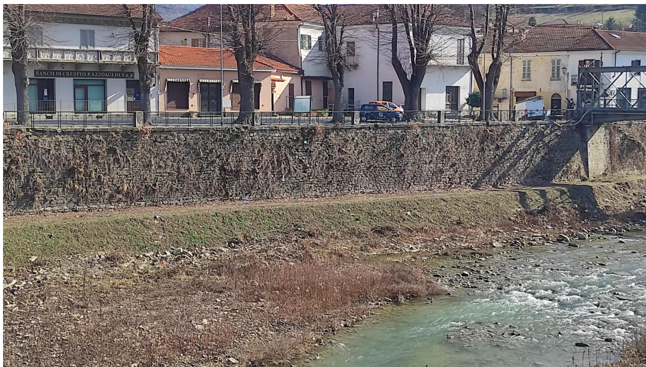
Figura 7 e 8: Sponda destra a valle del ponte pedonale, Intervento 9, sovrizzo muro esistente per assenza di franco idrometrico
