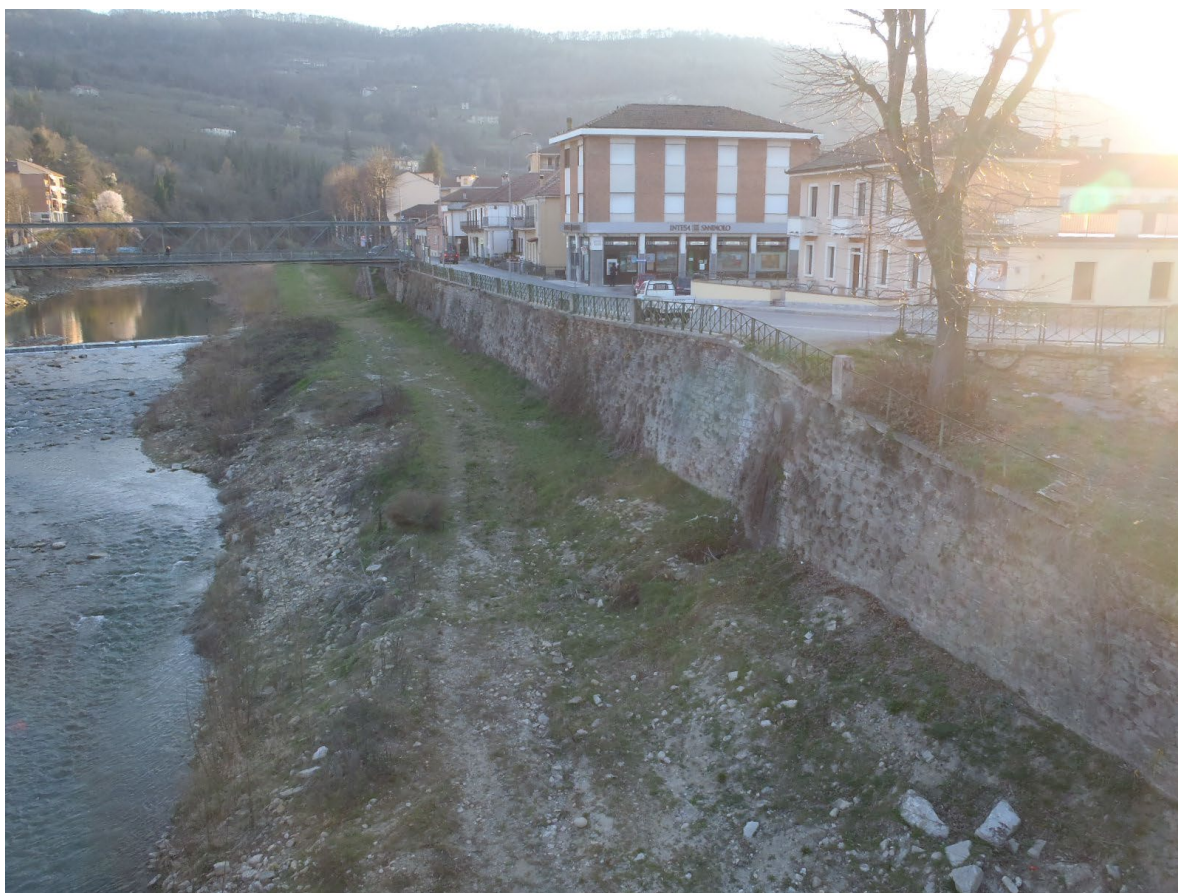
Figura 9: Sponda sinistra a monte del ponte sulla SP429, Intervento 8, sovrizzo muro esistente per assenza di franco idrometrico
