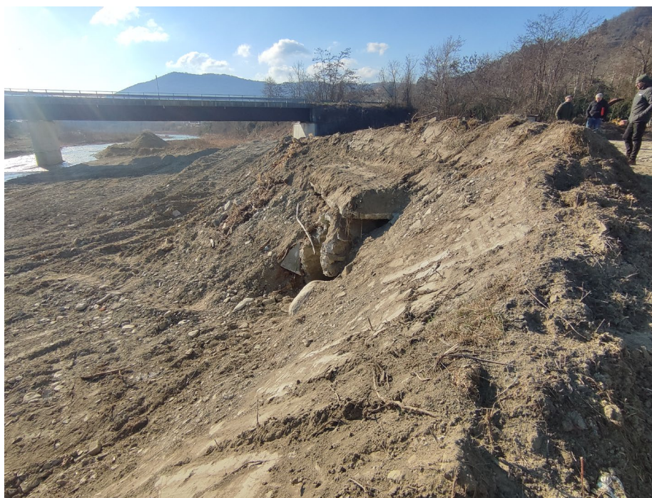
Figura 16 e 17: Sponda sinistra a valle ponte Olla, Intervento 6, realizzazione di scogliera per protezione sbocco cunicolo acque bianche
