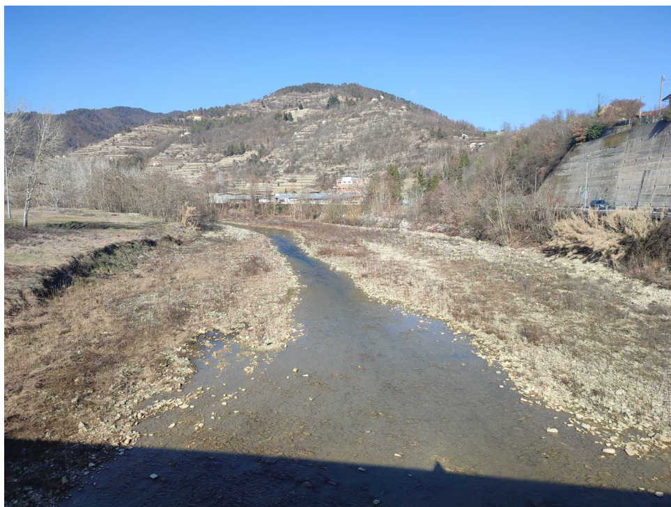
Figura 1 e 2: Sponda destra a monte ponte S. Rocco, Intervento 2, realizzazione di nuovo argine in terra per assenza di franco idrometrico
