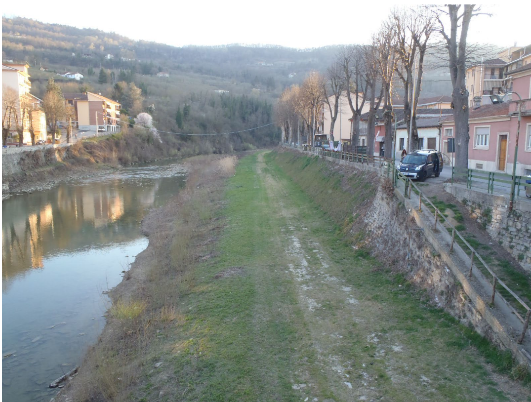
Figura 5: Sponda sinistra a valle del ponte S. Rocco, Intervento 8, sovrizzo muro esistente per assenza di franco idrometrico
