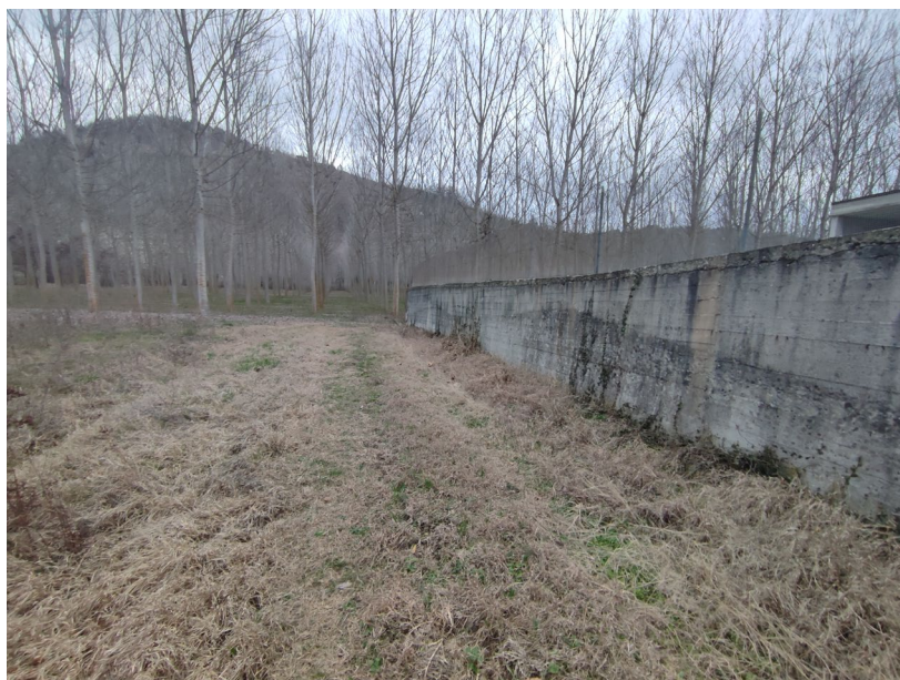
Figura 9: Sponda sinistra a monte del ponte sulla SP429, Intervento 8, sovrizzo muro esistente per assenza di franco idrometrico
